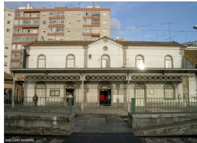
A estação do Cacém antes das obras de modernização http://farm9.static.flickr.com/8183/8096679207_e781045dc3.jpg
