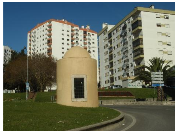
Respiradouros do aqueduto da Fábrica da Pólvora, Massamá
